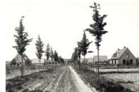
Woningbouw, Elisabethweg ca. 1925-1935 (bron: Coda).
