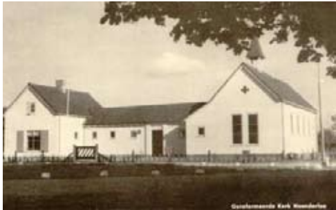
Vml. gereformeerde kerk aan de Krimweg, ca. 1960-1965 (bron: Coda).
