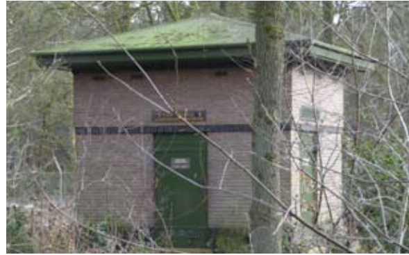
Delerwoud / Krimweg (trafohuis)
